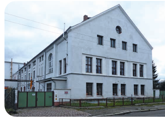
Halle an der Matthesstraße 91
