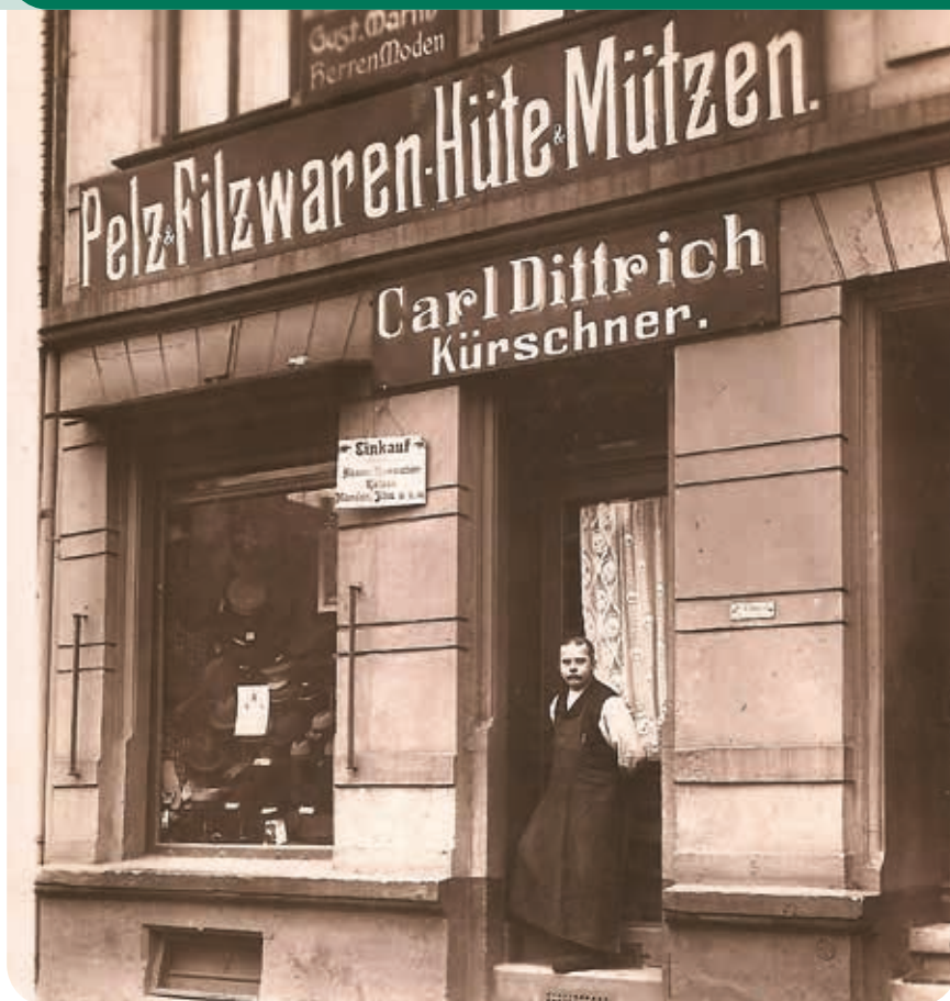
Carl Dittrich, Hartmannstraße 44 (1901)
